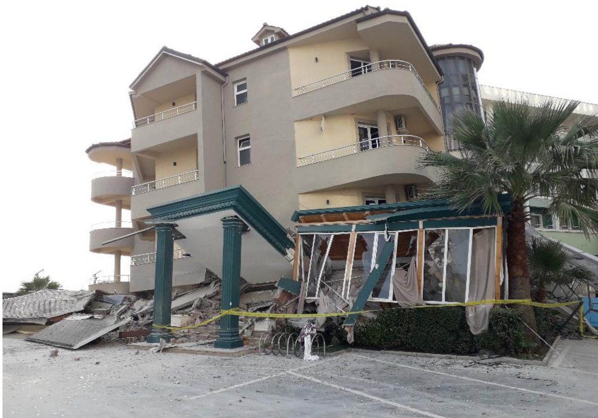
Slika 3. Hotel Vila Verde v Draču, na obali nekaj metrov od morja. Spodnji dve etaži zgradbe sta se med novembrskim potresom popolnoma sesedli (vir: https://www.emsc-csem.org/Files/news/Earthquakes_reports/Newsletter_15_2019_Albania_EQ.pdf )
