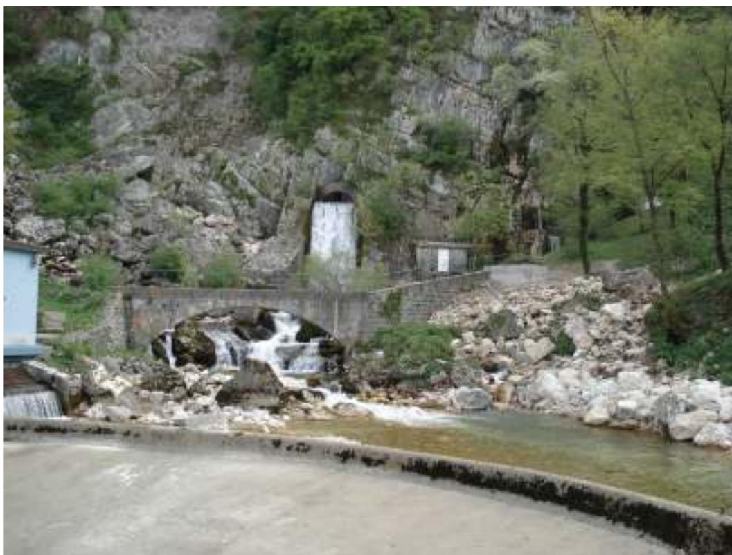
Slika 2. Nizko vodno stanje izvira Hubelj, april 2011 (N. Trišič) Figure 2. Low water condition of Hubelj spring, April 2011 (N. Trišič)
