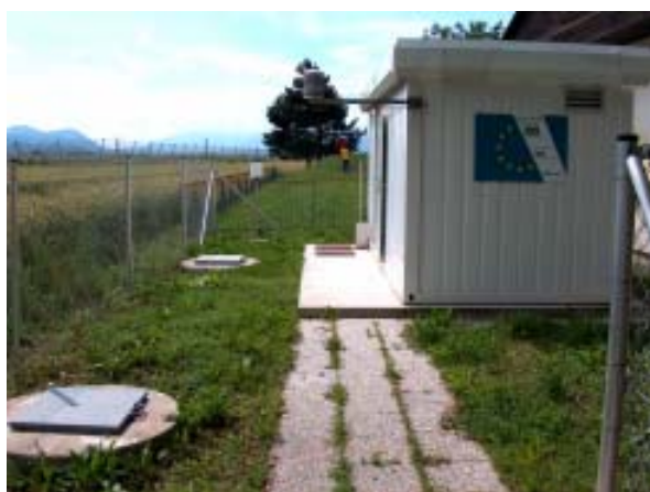
Slika 1. Avtomatska merilna postaja za spremljanje kakovosti podzemne vode v Sp. Savinjski Dol. Levec
