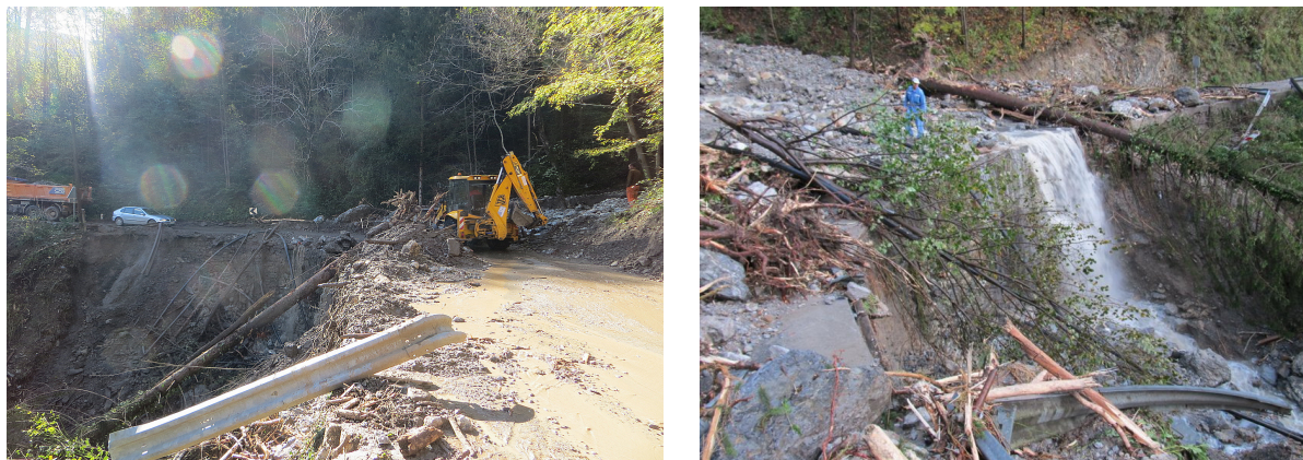
Slika 8: Hudourniške vode ob poplavih 22. oktobra so močno poškodovale ceste v srednjem Posočju (Vir: MMC).
