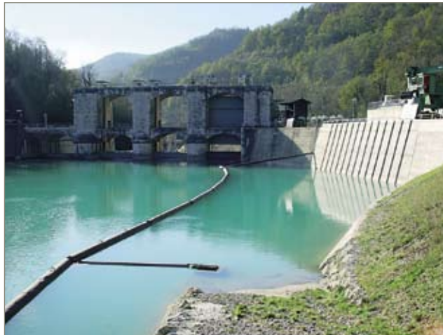
Dovodni kanal na Soči pred pregrado Ajba
